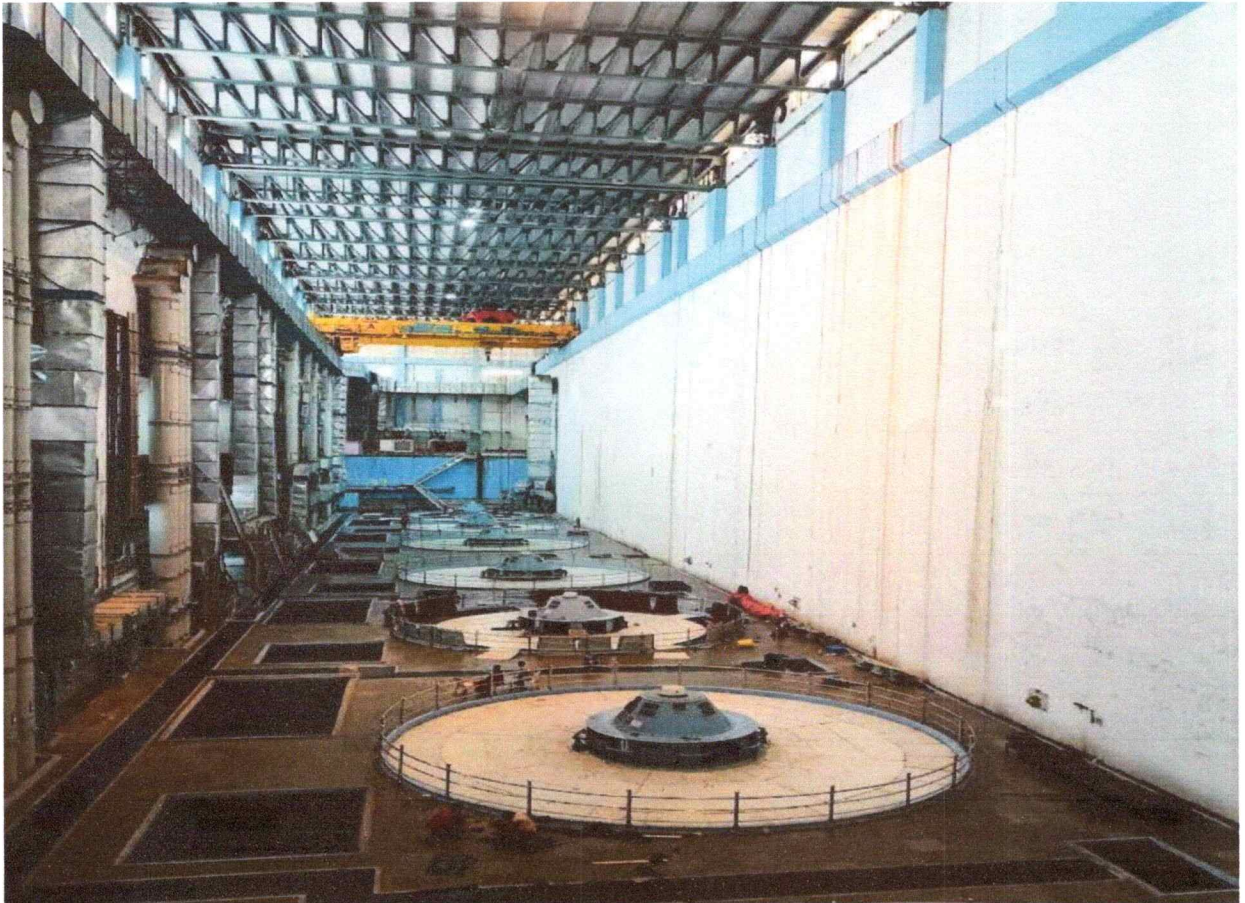
Fig. 7x110 MW Unit Generators
